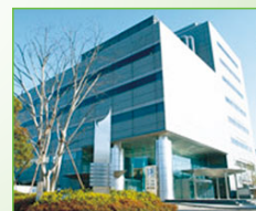
KVH東京 データセンター
